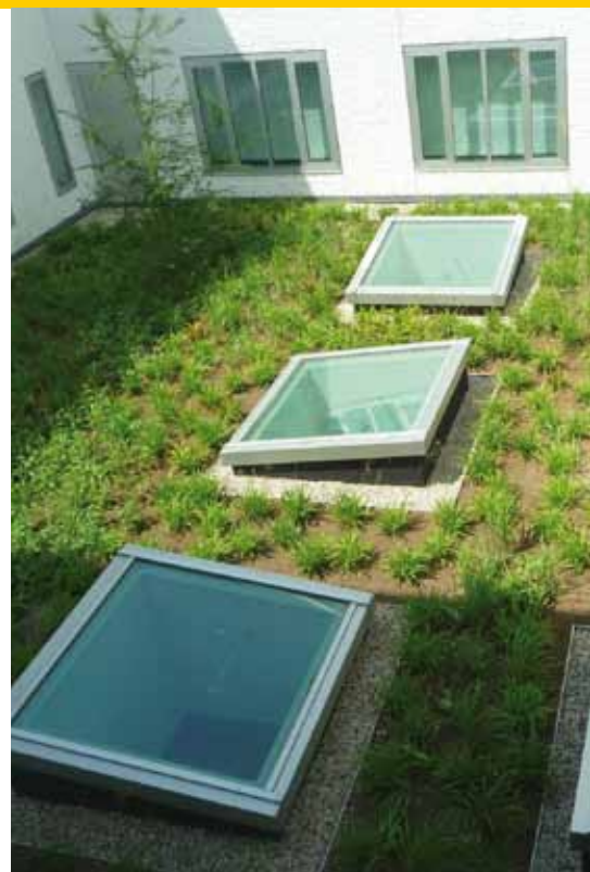
Het hellend dak boven de entree
