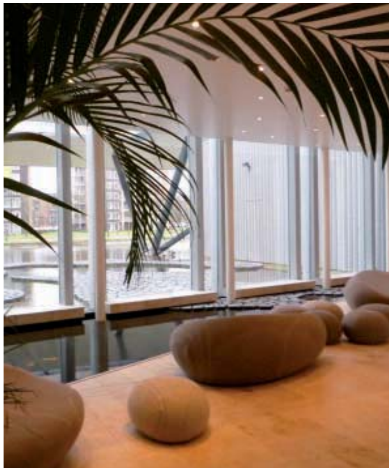
Het regenwater van het dak stroomt via verticale glazen goten tussen de glaspuien naar de vijver.
